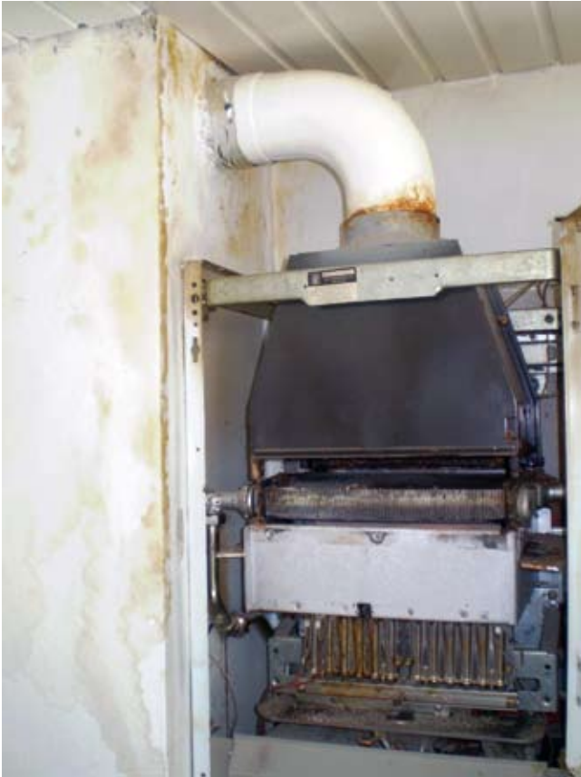
Et eksempel på en aftræksbøjning på en åben kedel før adskillelse.
